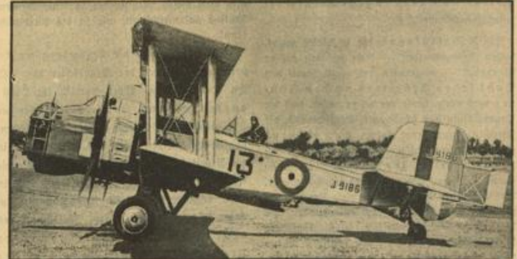
Das englische Luftfahrtministerium hat die Konstruktion eines neuen Kampfflugzeuges angenommen, das gepanzert ist, einen Geschützturm besitzt und bei 320 Kilometer Geschwindigkeit die gleiche Feuerkraft in der Luft hat wie auf dem Erdboden.
