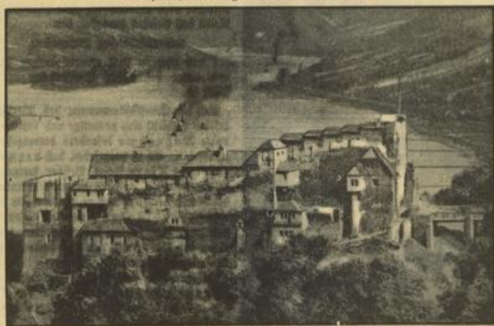
Am 18. November nimmt der Stadtführer der Reichsjugendführung, Obergebietsführer Hartmann Lauterbacher, auf der Jugendburg Stahleß bei Bacharach am Rhein die Grundsteinlegung zum Ausbau der größten deutschen Jugendburg vor.
