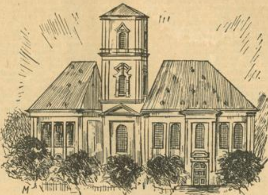
Der linke Bau ist die ehemalige Wallonenkirche, der rechte die heutige Konfordinienkirche vor dem Umbau
