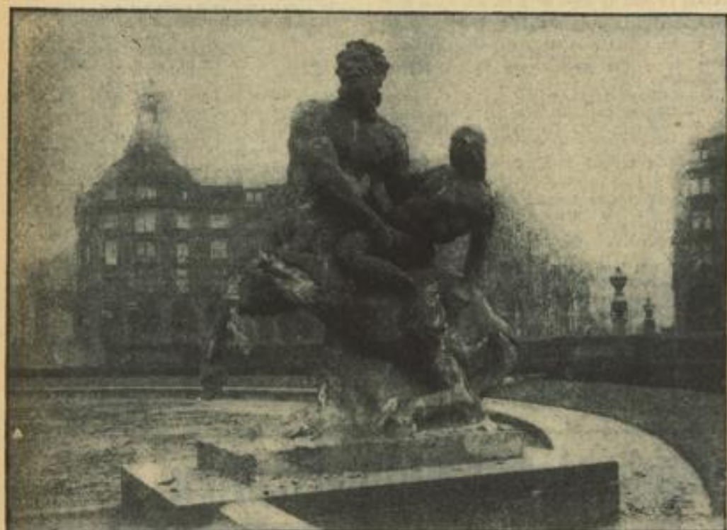
Das alte Bildwerk vor dem Abbruch im Jahre 1924. Gewaltige Risse und Sprünge machten seine Entfernung notwendig
