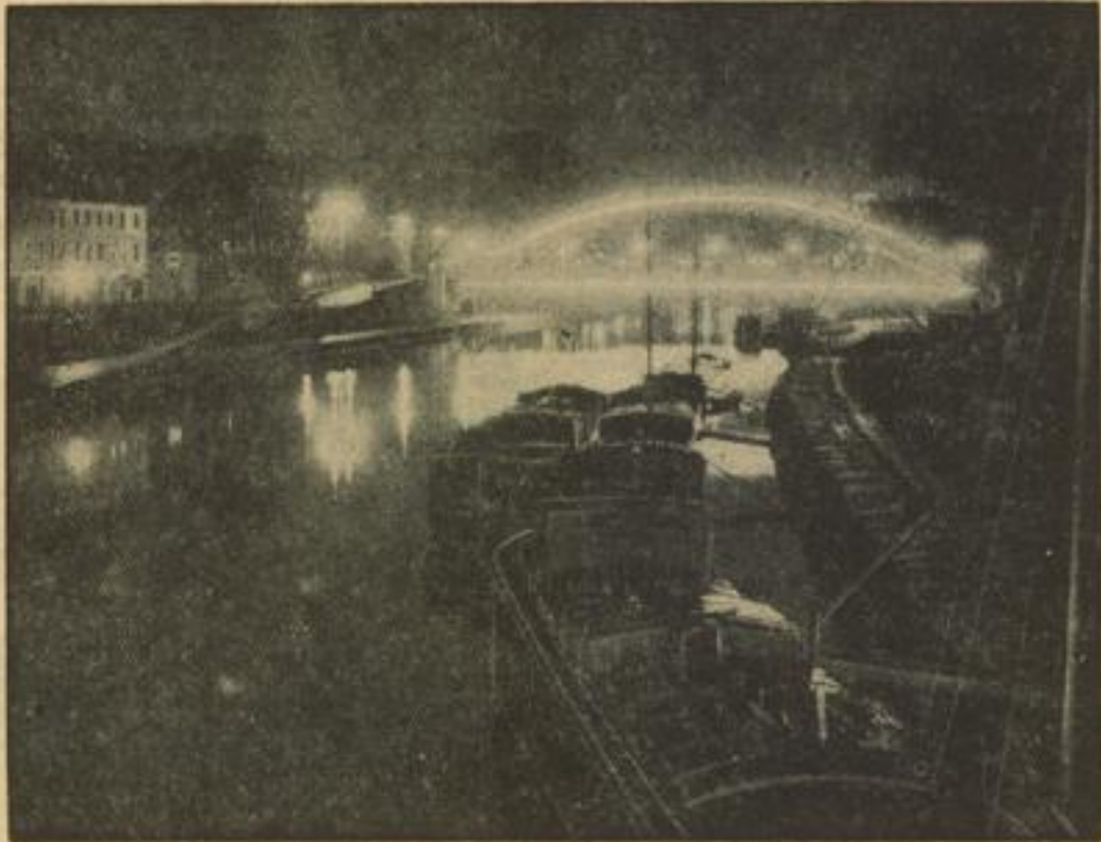
In der Woche vor dem Christfest - dem letzten vor der Rückkehr zum Reich - ist die Neue Brücke in Saarbrücken in festliches Licht getaucht
