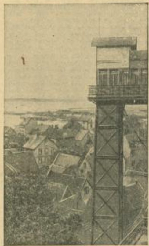
Der Fahrstuhl zwischen Oberland und Unterland und das charakteristische Dächergerüst der Fischerhäuser
