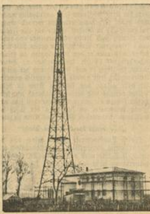
Der fast fertiggestellte neue Rundfunksender in Rohlfenz. 91 Meter hoch reckt der gewaltige Antennenmast seine Glieder in den Himmel.
