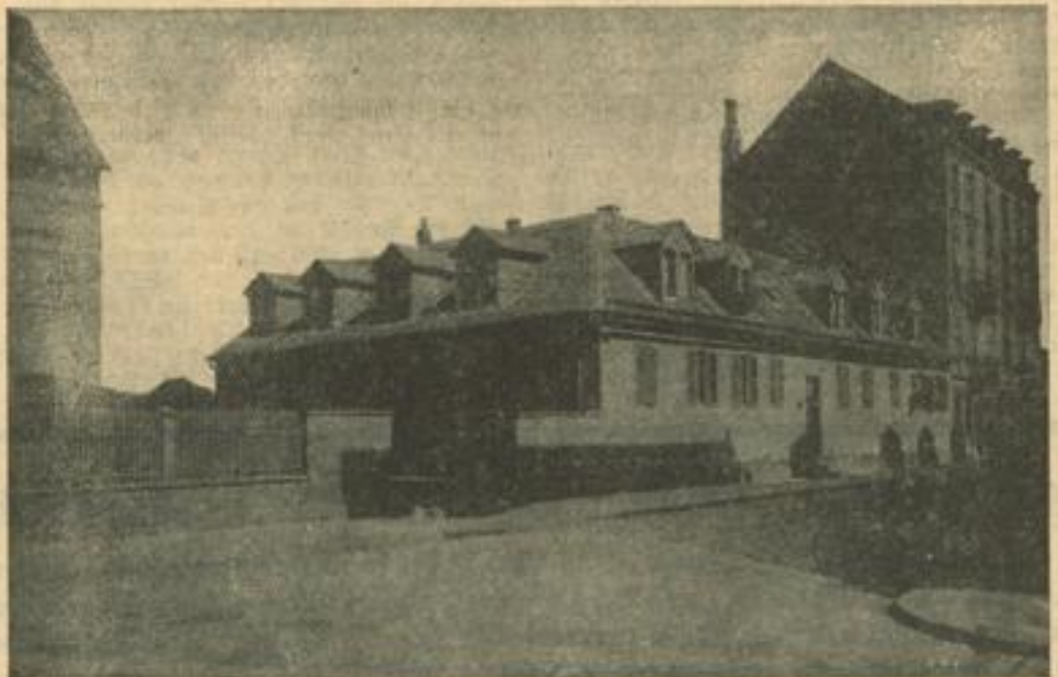
Die alte „Hasenhütte“
