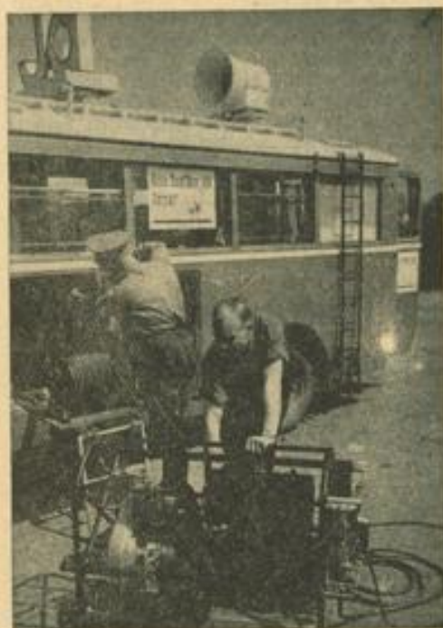
Die eigene Stromerzeugungsanlage
