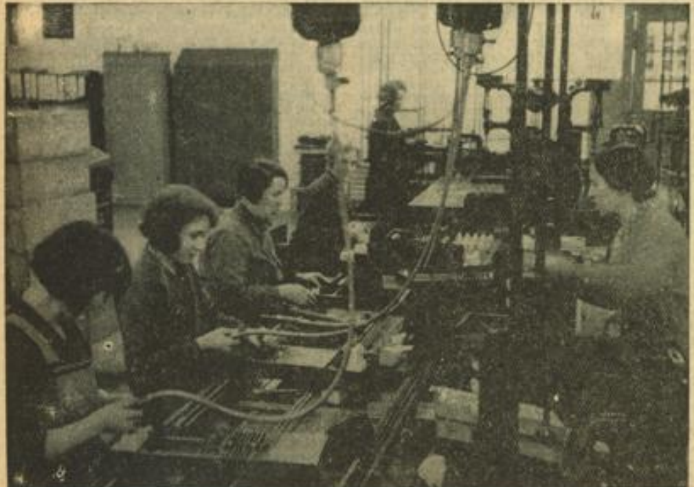
Montage der Zählertafeln mit maschinell angetriebenen Schraubenziehern
