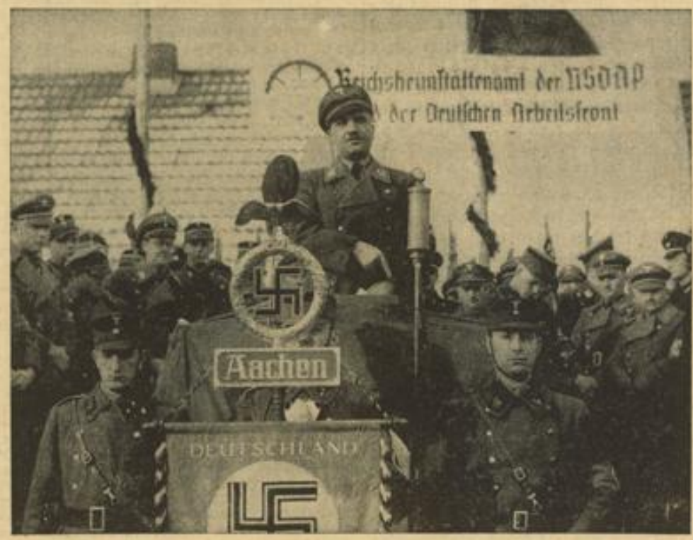
Reichsheimstättenamt der NSDAP und der Deutschen Arbeitsfront bauen 70 Siedlungshäuser für Bergarbeiter im Wurmrevier werden eingeweiht Reichsinspekteur Schmeer bei seiner Ansprache
