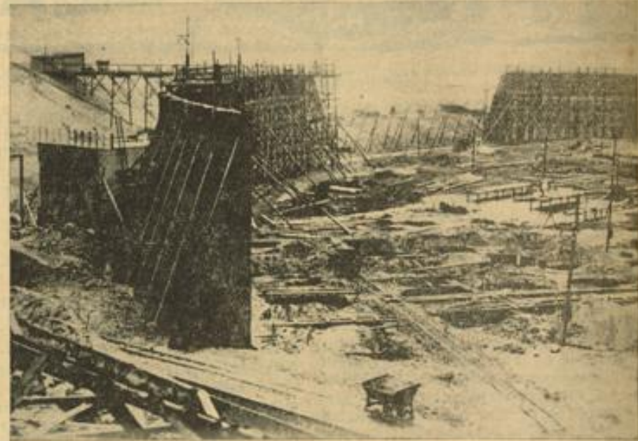
Der Bau der deutschen Kampfbahn auf dem Reichssportfeld in Berlin schreitet rüstig vorwärts. Die Erdarbeiten sind beendet, in der Westhälfte ragen schon die Grundmauern auf. Dieser Teil bleibt ganz untertunnelt, in ihn mündet die besondere Zufahrtsstraße für die Ehrengäste. Von hier aus erreichen die Teilnehmer ihre Umkleieräume. Die Betonierung der ganzen Anlage erfolgt nach Aufhören des Frostes.
