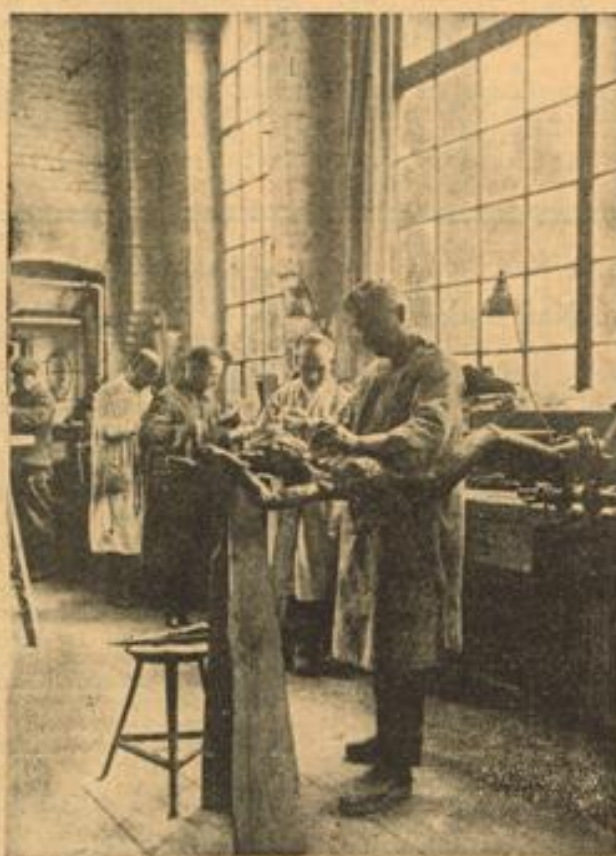
Vorne: So wird der „Kern“ für den späteren Abguß hergestellt
