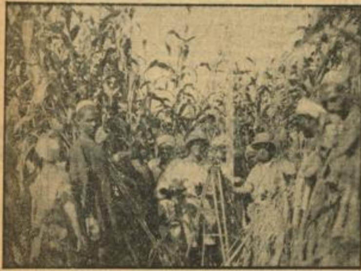
Oben links: Die Leitungsführung wird festgelegt und vermessen
