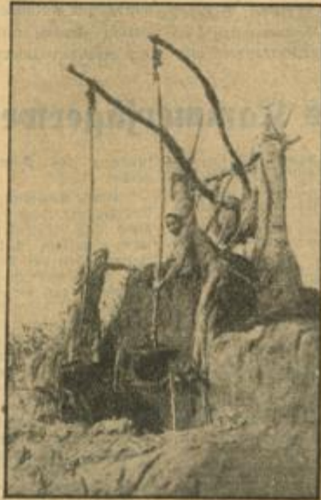
Schöpfwerke, wie sie zur Zeit der Pharaonen schon zur Bewässerung dienten.
