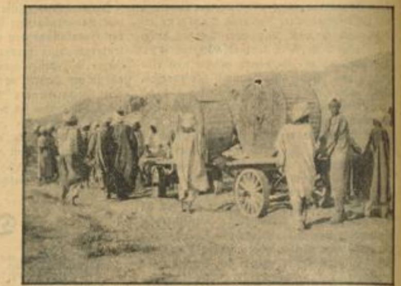
Oben rechts: Kabelrollen werden von Felladen an die Arbeitsstelle gezogen
