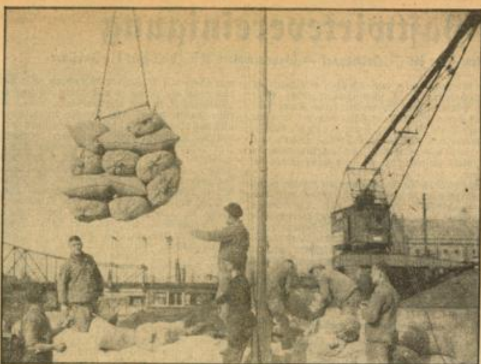
Verladearbeiten am Mannheimer Hafen
