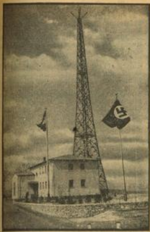
Deutschlands modernster Rundfunksender eröffnet in Rodens, ein Zwischensender des Reichsenders Frankfurt, wurde jetzt seiner Bestimmung übergeben. Die gesamte Anlage, mit deren Bau vor etwa einem halben Jahr begonnen wurde, ist die zur Zeit modernste Deutschlands. Der Antennenturm hat eine Höhe von 107 Metern. Photo: Deutsches Nachrichtenbüro
