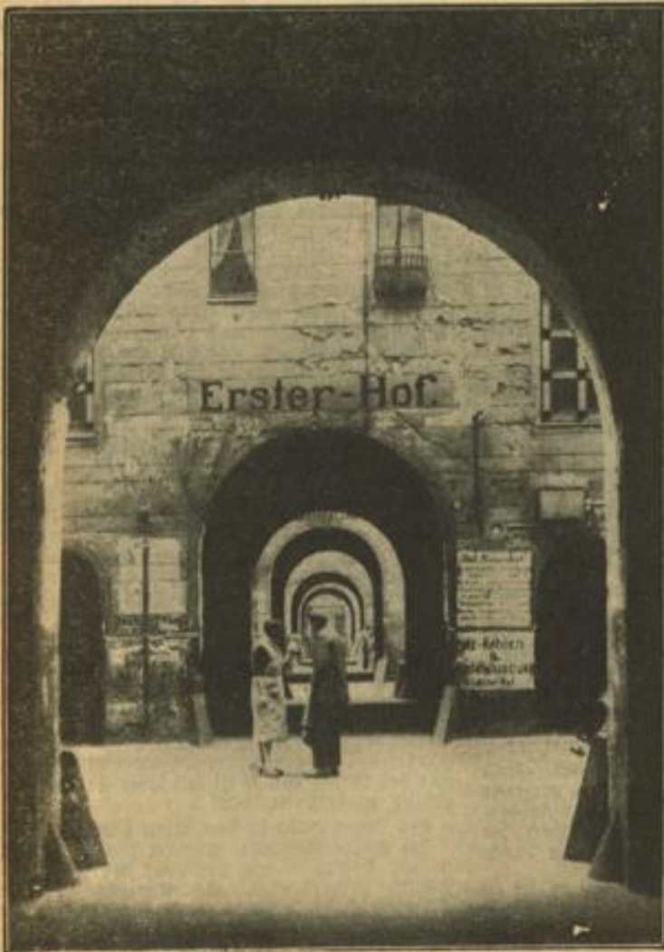
Fünf Hinterhöfe in einer Berliner Mietskaserne in der Alterstraße. Hier hat das 19. Jahrhundert bereits „Wohnmaschinen“ im sozial verderblichsten Sinn hervorgebracht
