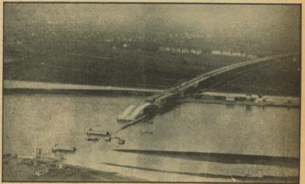
Autobahnbrücke im Bau (vor Seckenheim)
