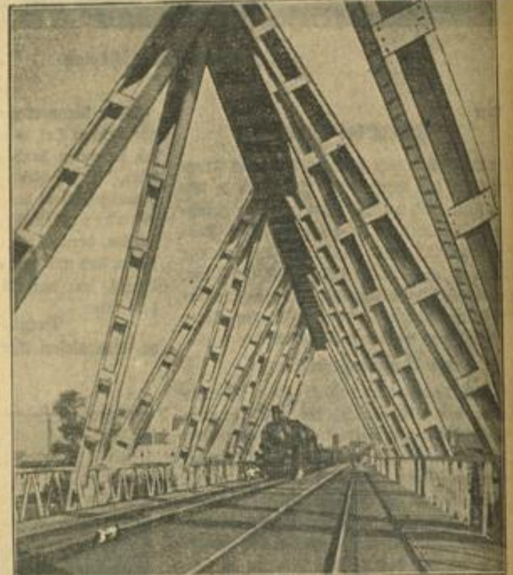
Weniger durch ihr Ausmaß ist die Eisenbahnbrücke bei Hammerstein auf der Strecke Berlin—Hannover bemerkenswert. Mit ihren mehr als 800 Meter wird sie von vielen Brücken übertroffen, und auch auf ihrer größten Stützweite von 106 Meter steht sie hinter anderen Balkenbrücken zurück. Bei Hammerstein mußte der Brückenbauer rechts und links des Stromes ein schwieriges Vorland überwinden. Für den
