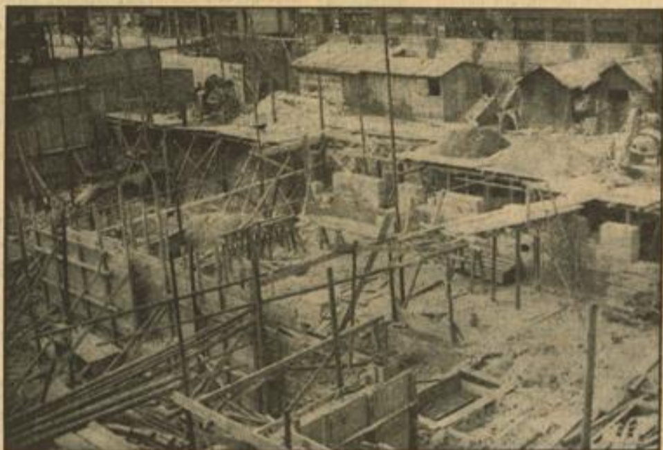
Aufbau-Arbeiten an den Planken... HB-Aufnahme und -Bildstock
