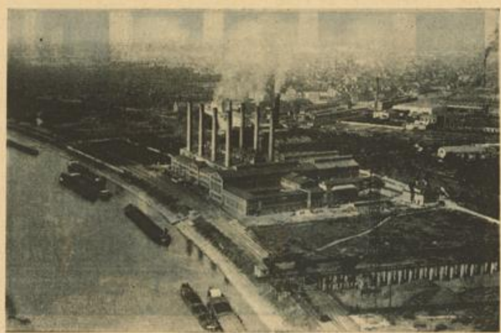
Das Großkraftwerk Mannheim aus der Vogelschau
