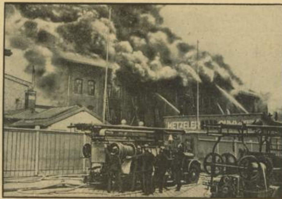
Großes Schandfeuer in München Bild auf die Brandstelle in den Gummilwerten Wegeler. Etwa 20 Tonnen Rohgummi sind den Flammen zum Opfer gefallen. Bei der schwierigen Befämpfung des Feuers wurden 20 Personen verletzt. Weltbild (M)
