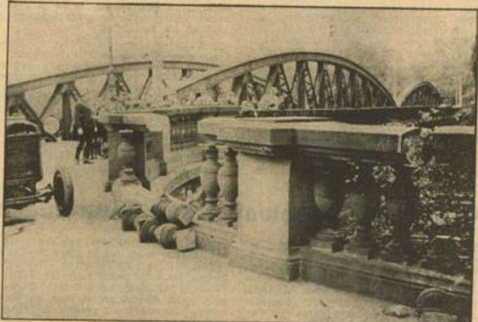
Blick auf das reichhaltige, steinerne Brückenbauwerk am Lindhof-Übergang, das von einem Lastkran- gertrümmer wurde. Glücklicherweise befanden sich im Augenblick des Unfalls keine Personen in der Nähe.
