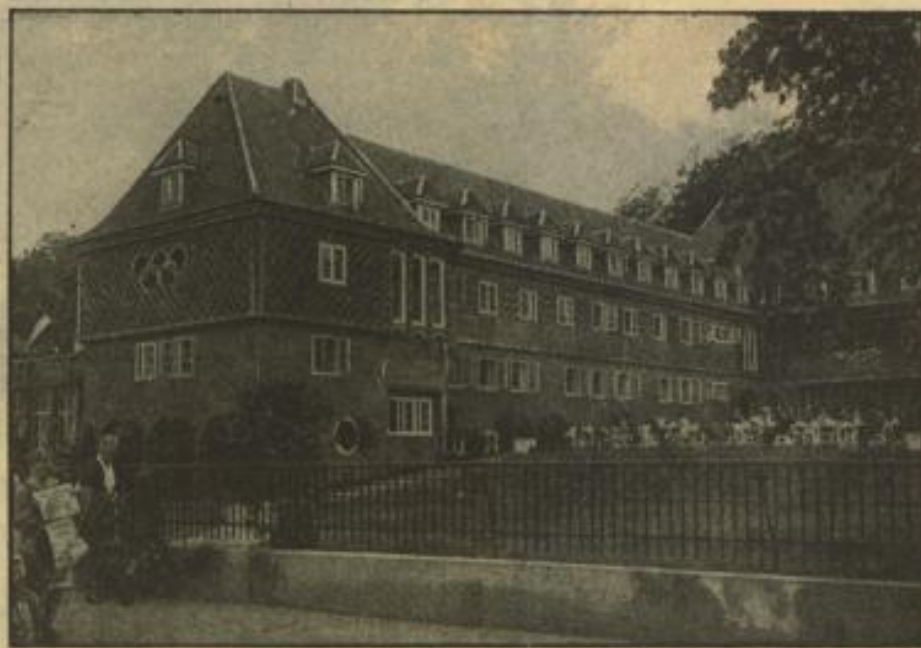
Das Olympia-Begehrheim in Kiel eröffnet Blick auf das Olympia-Begehrheim in Kiel, das 1 m Rahmen der Eröffnungsfeier zur Ritzler Woche der Stadt Kiel übergeben wurde. Das Gebäude wurde auf Anregung des Reichsstaatssekretärs für die Vegetationsperiode 1935 errichtet. Weibild (6)
