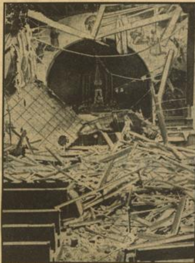
Kirchenruine durch Erdbeben in Württemberg. Bild in das Innere der Kirche von Rappel wurde von Wagon, wo durch ein Erdbeben, das in ganz Süddeutschland verspürt wurde, das Querschiff schwer beschädigt wurde.
