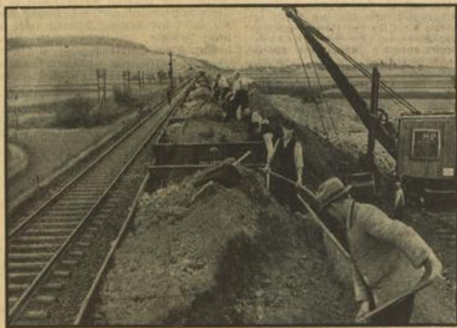
Bereitungen zum Reichstagsgebäude auf dem Bäderberg. Mit Hochdruck wird an der Verbreiterung des Bahndammes beim Bahnhofs Lindern am Fuße des Bäderberges gearbeitet, wo zwei neue Gleisanlagen geschaffen werden, um den Anmarsch der Zeitnehmer bewältigen zu können. Im Hintergrund der Bäderberg. Weichbild (M)
