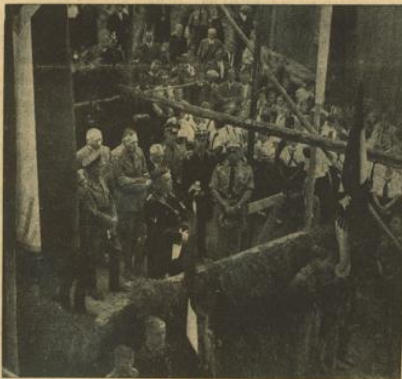
Grundsteinlegung der neuen Schwarzwaldb-Jugendherberge
