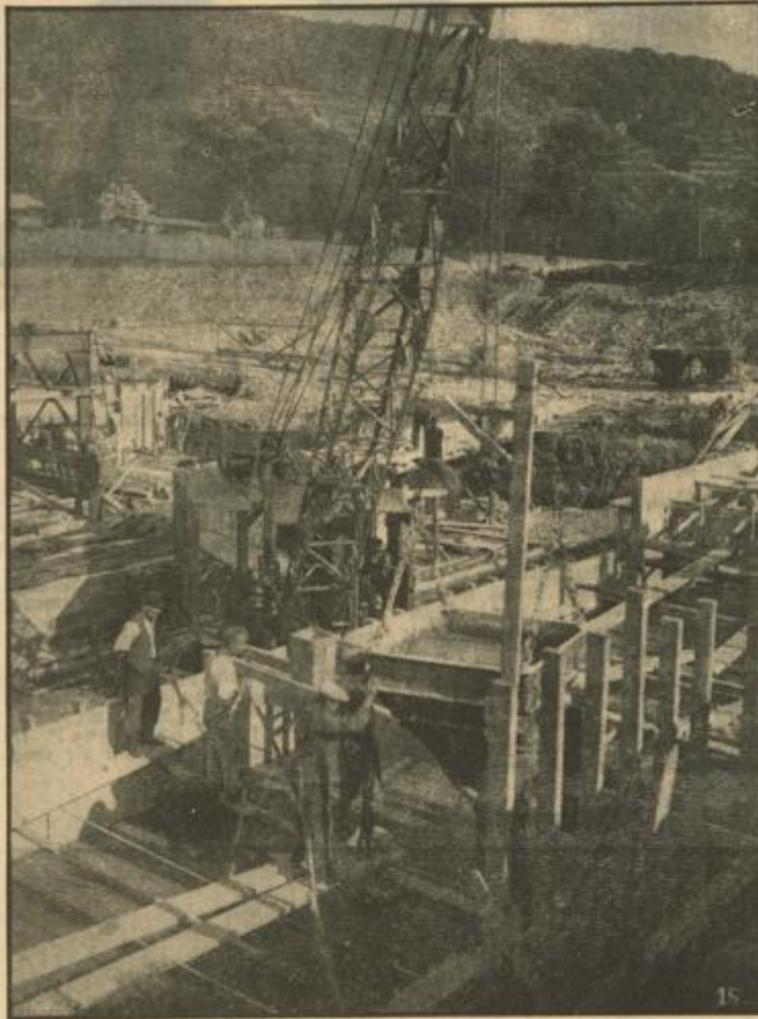
Betonierungsarbeiten während des Baues der Staustufe Neckarzimmern
