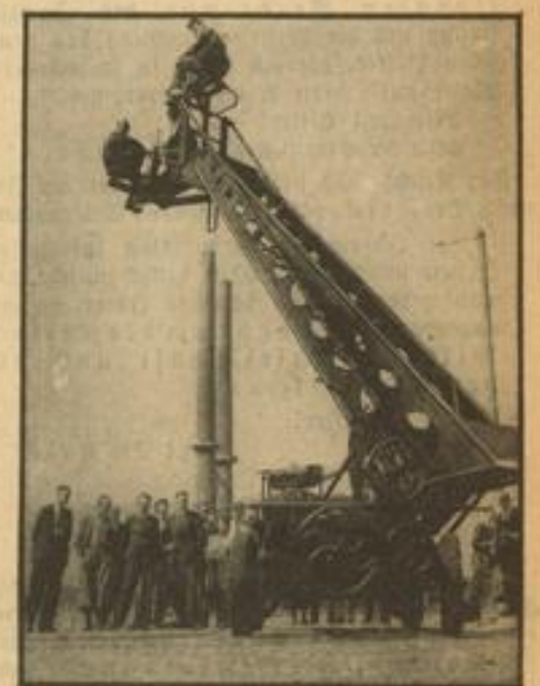
Neue geräuschlose Drehwerke für Filmateller Eine holländische Firma hat einen neuartigen Dreh- und Hebeturm konstruiert, der völlig geräuschlos nach allen Richtungen gedreht werden kann. Auf dem Turm hat der Filmoperateur, der Regisseur und eine Person, die das Mikrophon bedient, Platz. Presso-Bild-Zentrale HB-Bildstock
