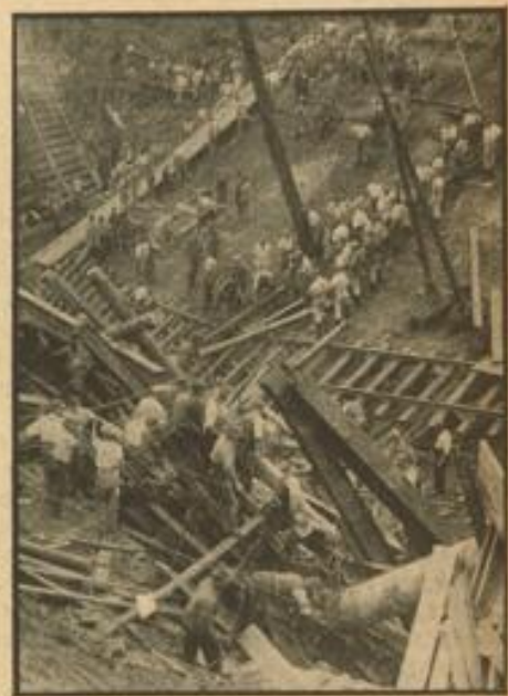
Nach dem Unglück beim Bau der Nord-Süd-S-Bahn am Brandenburger Tor
