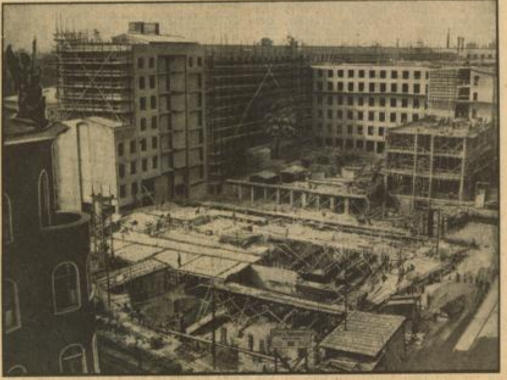
Der Neubau des Reichsjustizministeriums Bild auf die Neubaurbeiten von der Ecke Bismarckstraße-Prinz-Albrecht-Straße aus gesehen. Im Hintergrund die im Rohbau bereits fertiggestellten Gebäudeteile. Wetzelbild (M)
