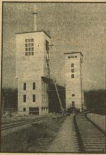
Gaswerkneubau Der Turm mit Tisch- und Radionote
