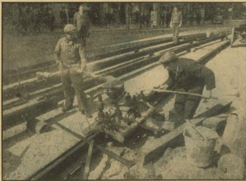
Am den neuen Pfaffen werden die freigelegten Straßenbahnlinien geschweißt
