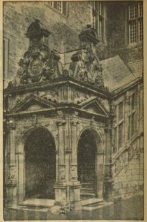
Ein Schulungslager für westfälische Studenten. Der schöne Renaissance-Treppenaufgang des Schlosses Seelen. Das Schloss, eine der schönsten Wasserburgen Westfalens, soll zu einem Schulungslager für westfälische Studenten umgestaltet werden.
