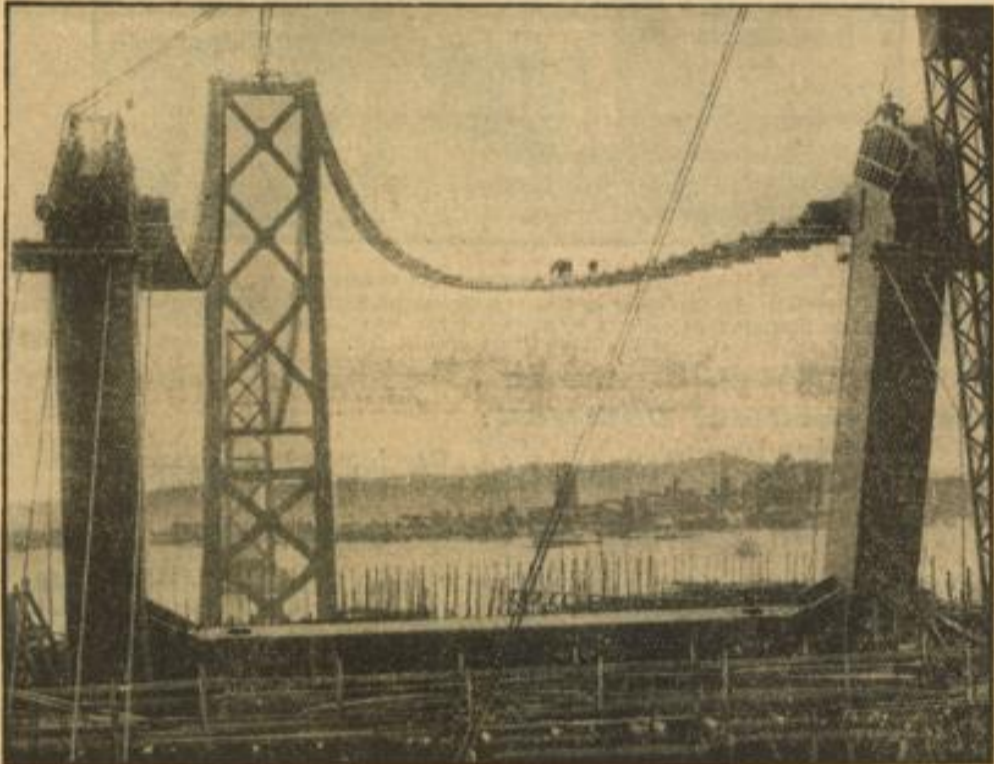
Riesendeckel über das „Goldene Tor“ im Verden. Der sogenannte „Rahengang“, der miteinander verbundenen Räder, an denen die Faserbahn aufgehängt wird, ist jetzt vollendet worden. Die im Bau befindliche Brückenkonstruktion über das „Goldene Tor“ bei San Francisco ist die größte aller Zeiten. Weibild (M)
