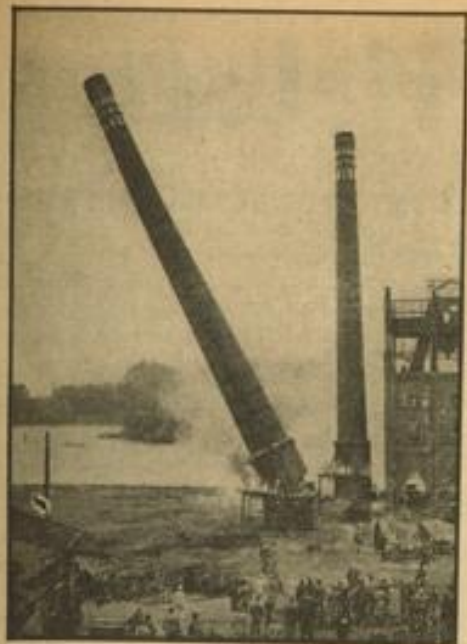
Niederlegung der Schornsteine beim alten Spandauer Gashwerk
