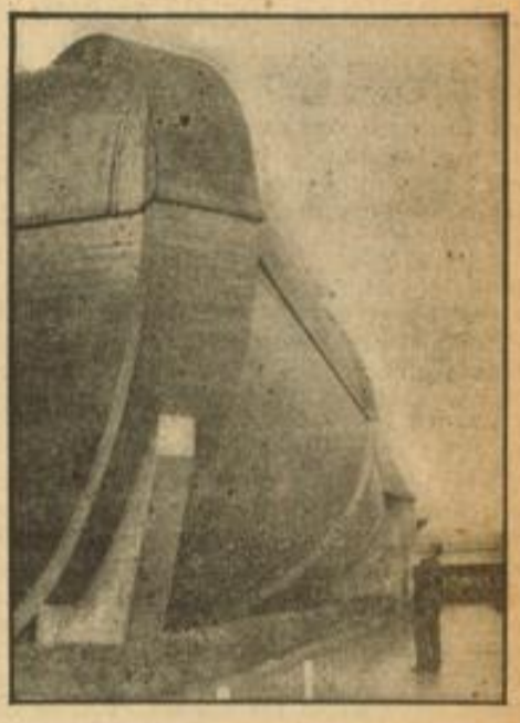
Die Sturmmaschine. Bild auf den gigantischen Windmühl im Luftfahrt-Forschungsinstitut in Berlin-Adlershof, durch den die Luft durch einen 2700-PS-Motor bis zu einer Umlaufgeschwindigkeit von 250 Stundenkilometer geleitet wird. Presse-Bild-Zentrale HB-Bildstock
