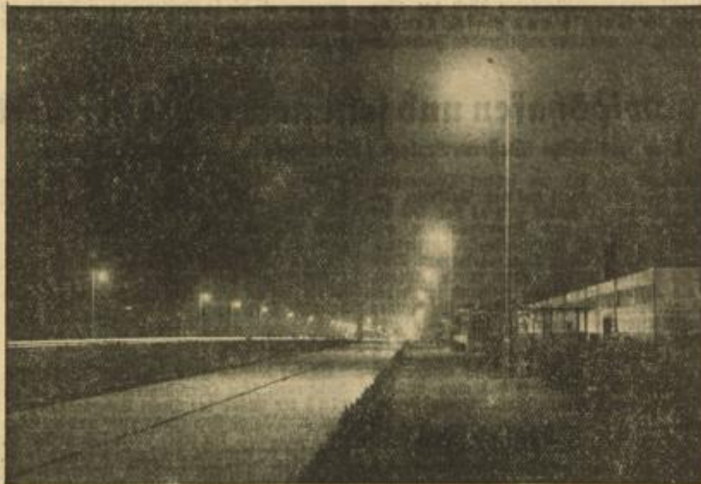
Die hell erleuchtete Einfahrtstrecke in Mannheim
