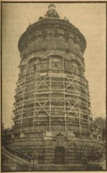
Seit einigen Tagen ist der Wasserturm mit einem Gerüst umgeben, um dem Schmutz energisch zu Leibe zu gehen. Foto: Franck - Bildstock
