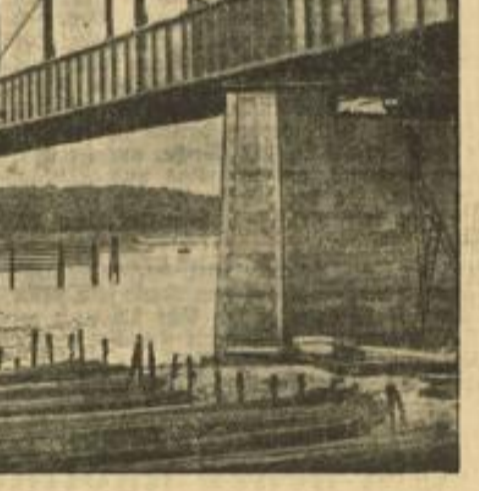
Die neue Eisenbrücke bei Dömitz. Die neue Brücke, die bei Dömitz über die Elbe führt, ist so weit fertiggestellt, daß jetzt mit dem Legen der Straße und der Aufbaustrommen begonnen wird.
