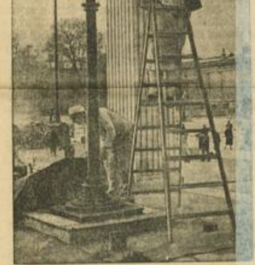
Rechte Arbeiten am Königsplatz für den 9. November
