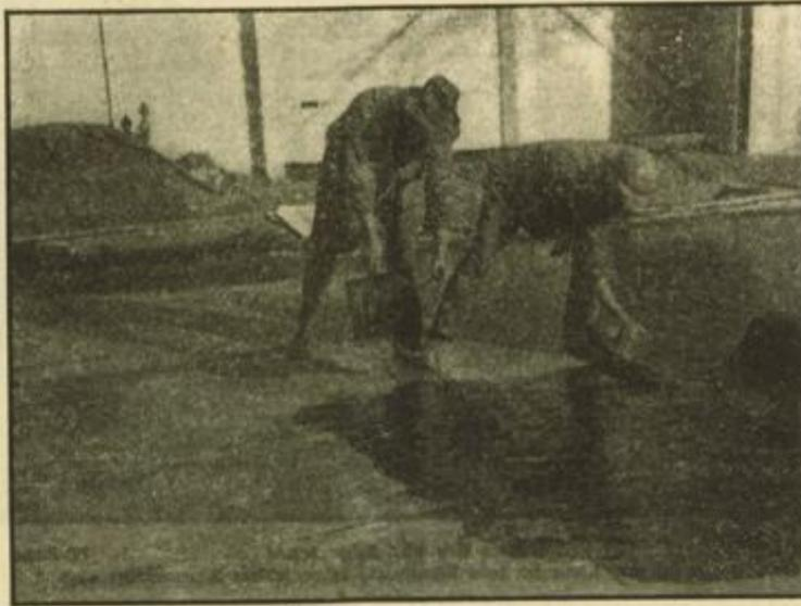
Die früheren engen Planken werden asphaltiert. Rüstig schreiten die Straßenarbeiten vorwärts und bald wird eine spiegelglatte Fahrbahn das Herz des Kraftfahrers erfreuen.
