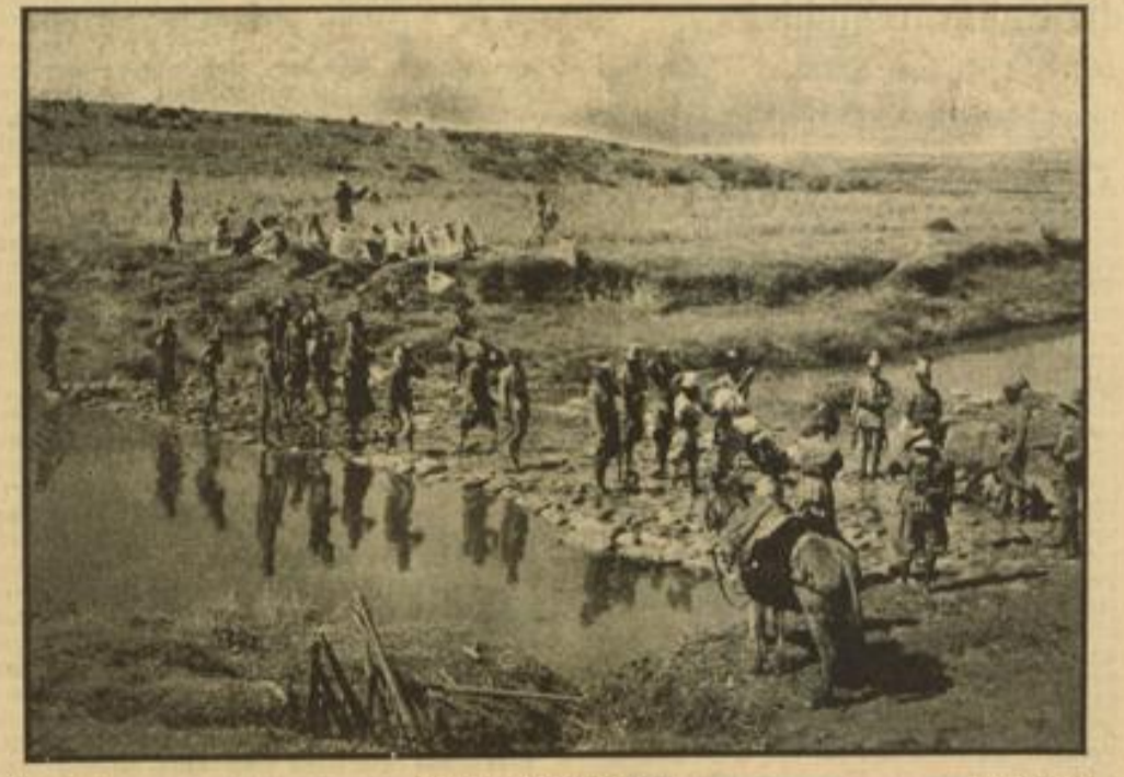
Pressbild Auch das ist Straßenbau! HB-Bildstock Auf dem Vormarsch nach Makalle hatten die italienischen Truppen Schwierigkeiten der verschiedensten Art zu überwinden. Sie haben hier eine Wasserstelle durch einen Damm aus Stein überbrückt.
