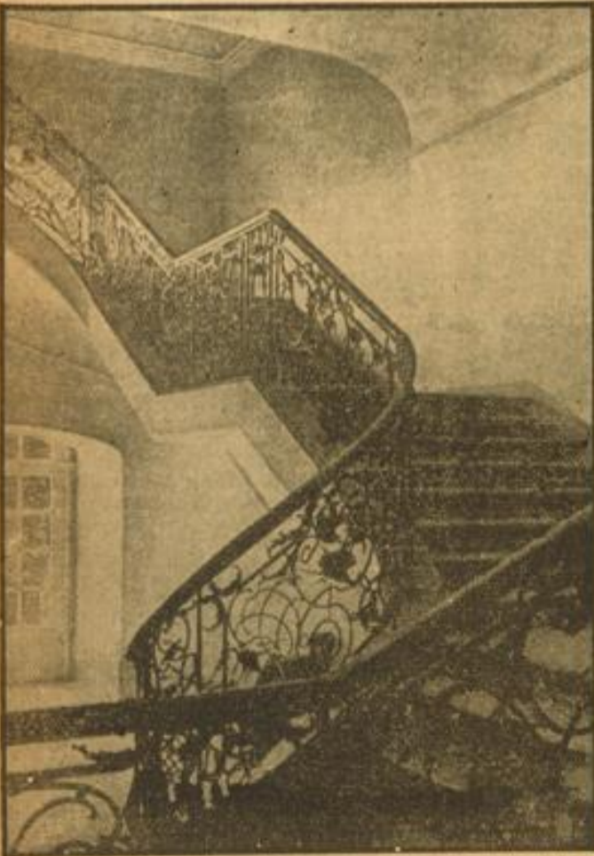
Im Meisterstück des Schmiedehandwerks: schmiedeeisernes Treppengeländer in der Gemäldegalerie bei Sanssouci.
