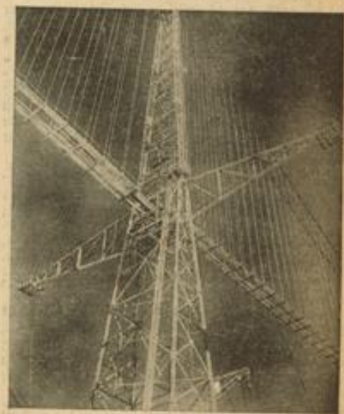
Presso-Photo Die Hängebrücke Ein selten schönes Bild des Pfeilers einer Hängebrücke. Die Hängebrücke dient zur Beförderung des Materials zum Bau des Großen Coulee-Dammes, der einer der größten Dämme der Welt werden soll.
