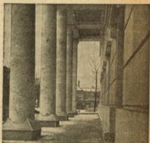
Die Gerüste sind gelassen. Der Säulenbau des Hauses der Kunst in München.
