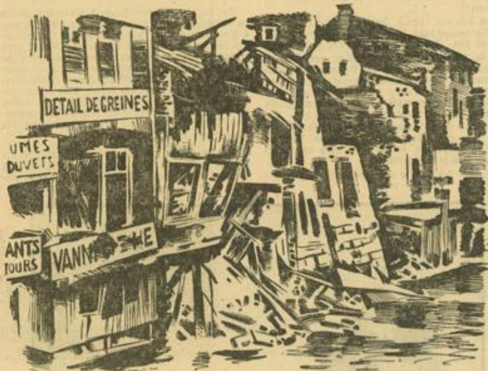
Zerschossene Häuser in Verdun
