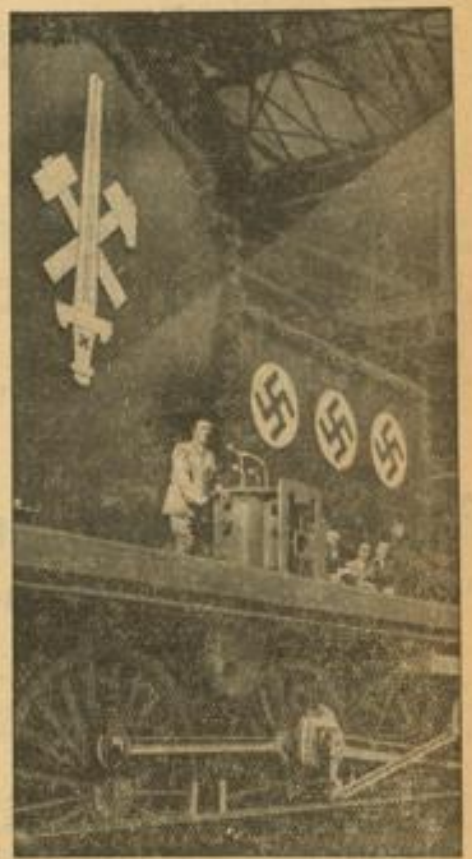
Die denkwürdige Essener Großkundgebung am 27. März. Der „erste Arbeiter der Nation“ spricht von dem auf eisernen Trägern der Maschinenhalle der Krupp-Werke errichteten Podium zu den Männern der Ruhr und darüber hinaus zu den Millionen deutscher Arbeiter. Weltbild (M)
