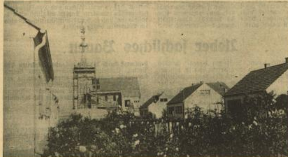
Zwischen Käffertal und Waldhof ist in der Siedlung die erste Siedlerkirche im Bau. Ein Gerüst umgibt den gegenwärtig im Entstehen begriffenen Turm der Kirche. Aufn.: Jütte
