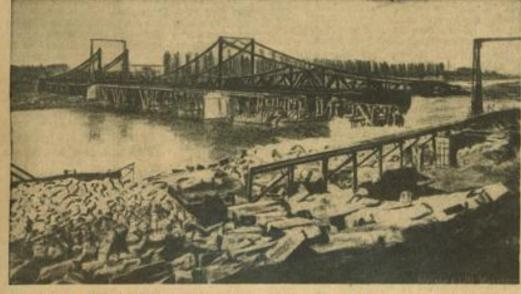
Ein wichtiger Bauabschnitt der Friedrichsbrücke aus dem Jahre 1890: Die schlanke Eisenkonstruktion wird aufmontiert
