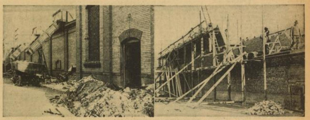
Abbruch und Wiederaufbau gehen in dem abgebrannten Kühlhaus des Schlacht- und Viehhofes Hand in Hand. Auf der nach der Seckenheimer Straße zu gelegenen Seite wird noch der Abbruchschutt durch Rutschen weggeschafft. Das Bild rechts zeigt die „Aufstockung“, die einmal dazu bestimmt ist, die eigentliche Kühlanlage aufzunehmen. (Aufnahmen: Hans Jütte (1))
