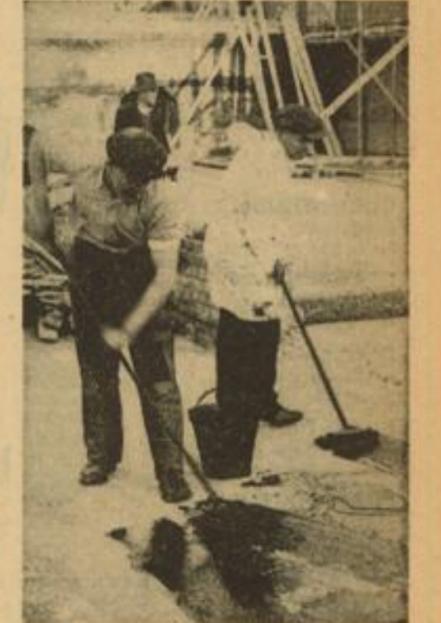
Die neue Hauptdecke des wiederaufgebauten Kühlhauses ist bereits fertig. Ehe die Isoliermasse eingebaut und eine weitere Betondecke darüber gegußt wird, erfolgt das Auftragen einer Isolierung.
