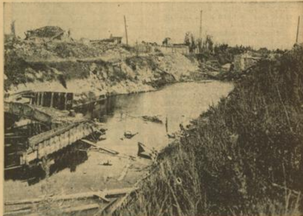
Der Kanal in La Bassée mit zerstörter Brücke
