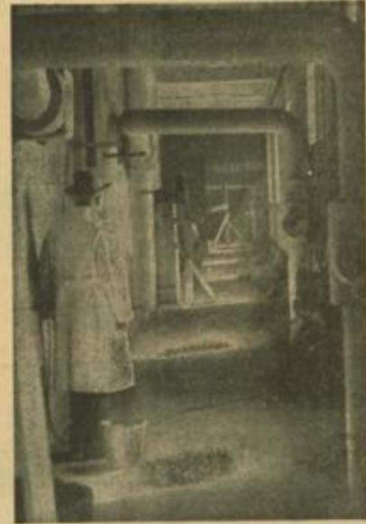
Ein Blick in das Innere des neuen Aufbaues im Rühlhaus. Von hier aus wird von vier Stellen aus die kalte Luft von oben nach unten in feuersicheren Kanälen in die Kühlhallen gedrückt.
