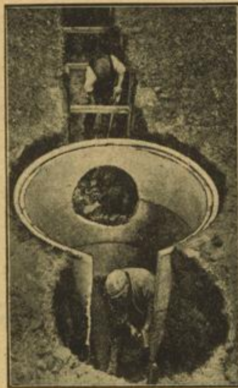
Englischer Luftschutzzraum aus Zementröhren. Nach den Luftschutzzräumen aus Wellblech versucht man jetzt in England ein neues Bausystem. Riesige Betonringe werden aneinandergekoppelt und in die Erde gegraben, und sollen den Insassen die Möglichkeit geben, einen anderen Ausweg zu nehmen, wenn der Haupteingang verschüttet ist. (Scherl-Bilderdienst-M)
